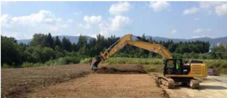
Abbildung 14 Bodenauftrag im Streifenverfahren [f]
